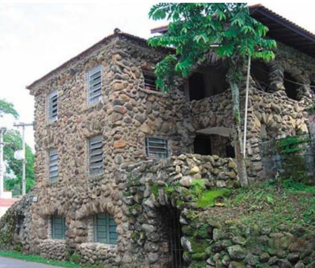
Vista parcial da "Casa de Pedra", construída por Toivo Ascigane, um dos primeiros guardadores do sábado entre os finlandeses de Penedo. O "castelo" foi posteriormente comprado pela Igreja Adventista, por 200 mil réis, em 1952, para ser sede de acampamentos
